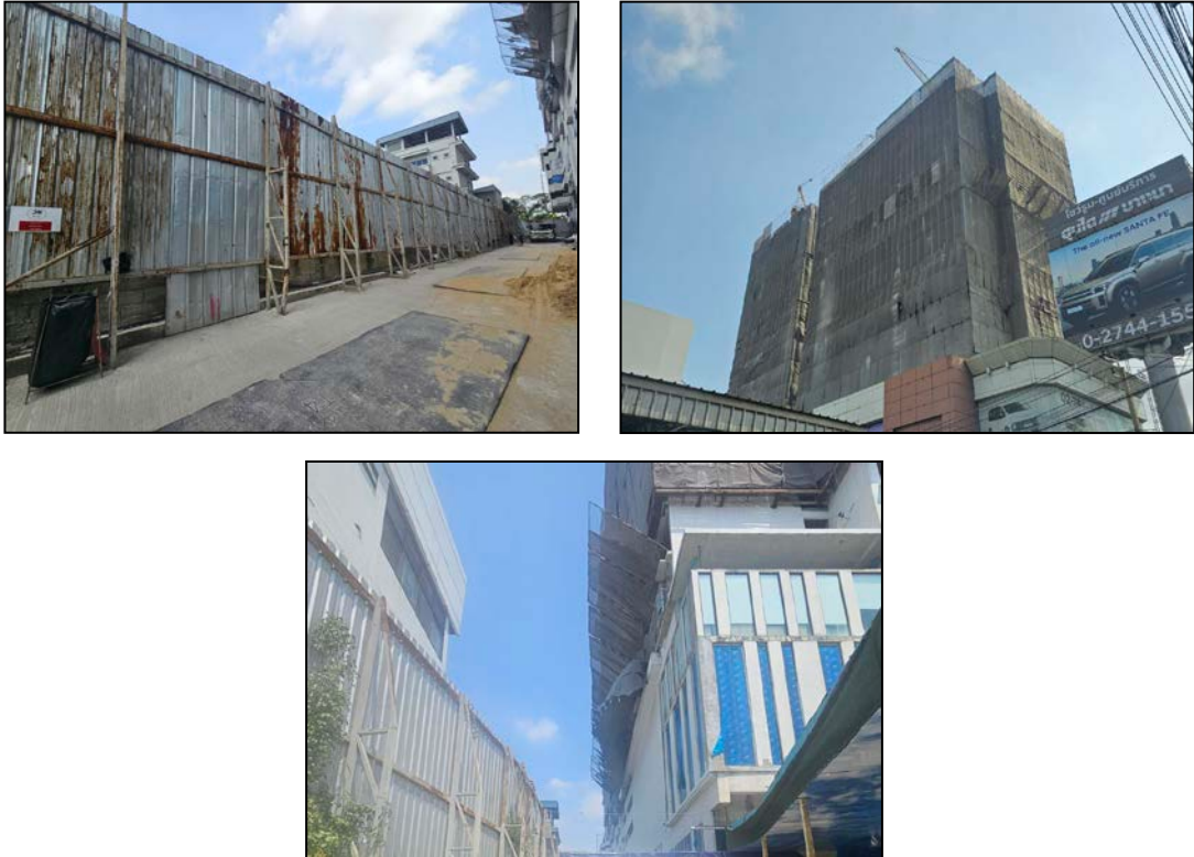
รูปที่ 2.1-1 รั้ว Metal Sheet รอบแนวเขตที่ดินและผ้าใบคลุมรอบอาคาร พร้อมติดตั้งแผงกันวัสดุตกหล่น
