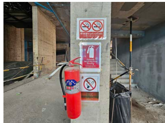
รูปที่ 2.1-17 ถังดับเพลิงเคมี
